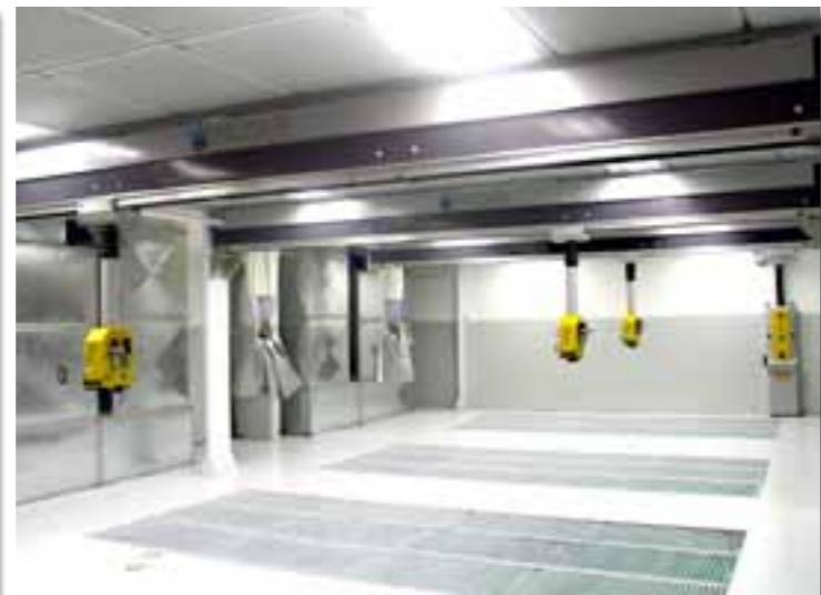
Modular Service Line consente di equipaggiare la carrozzeria in maniera modulare consentendo l'illuminazione della zona di lavoro e di fornire energia, aria compressa e aspirazione tramite centraline scorrevoli. Il supporto a catenaria consente il trasporto di tubi flessibili e il collegamento alla tubazione centralizzata di aspirazione.
